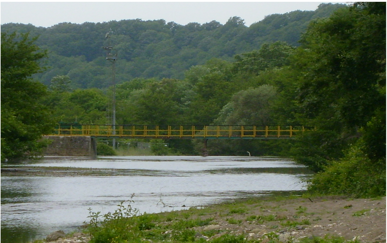
Fig. 2 - Opera di sbarramento fluviale sul Mignone subito a valle della confluenza con il Fosso del Rafanello
